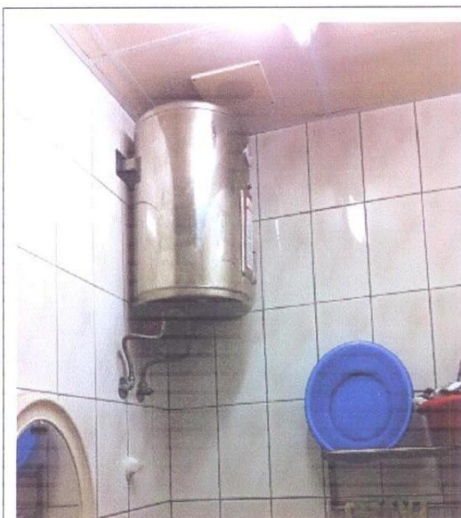
圖五、設置電熱水器
