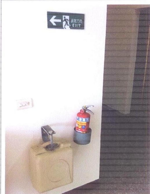
圖七、逃生指示滅火器放置正確地點
