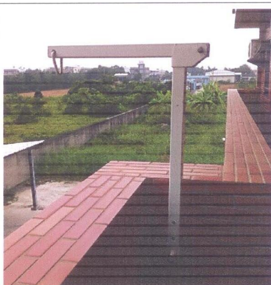
圖六、設置逃生設備
